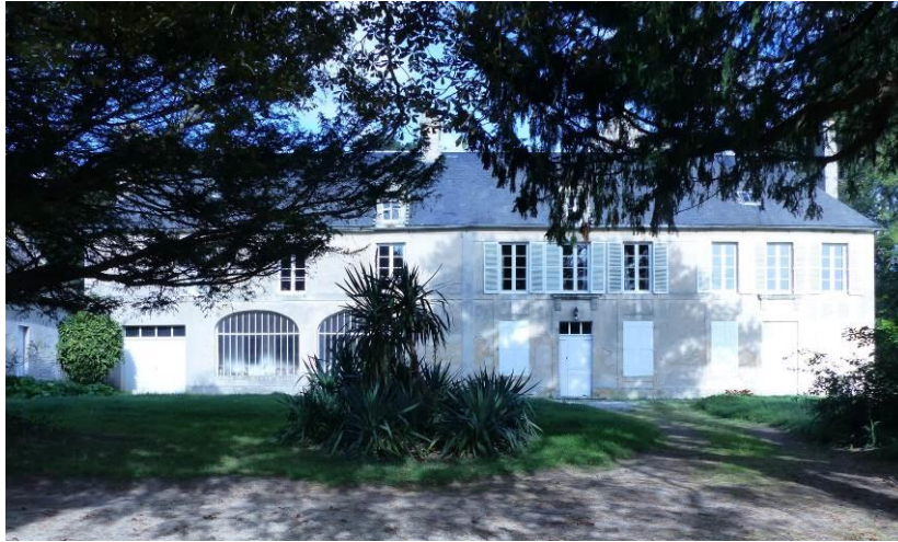
Figure 4 - Façade sud du manoir de la Baronnie
