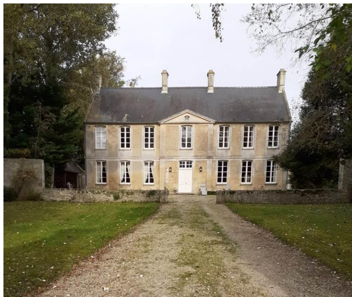
Figure 3 - Corps de logis de l'ancien presbytère
