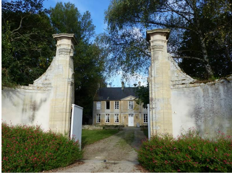
Figure 2 - Portail de l'ancien presbytère
