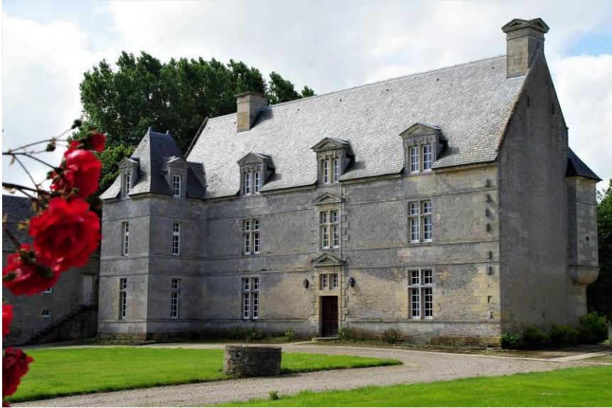
Figure 11 - Façade sur cour de la Grande ferme
